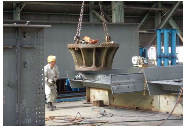
ベテランによる歪み矯正の様子
