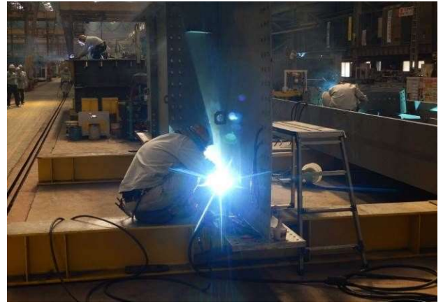
溶接作業の様子
