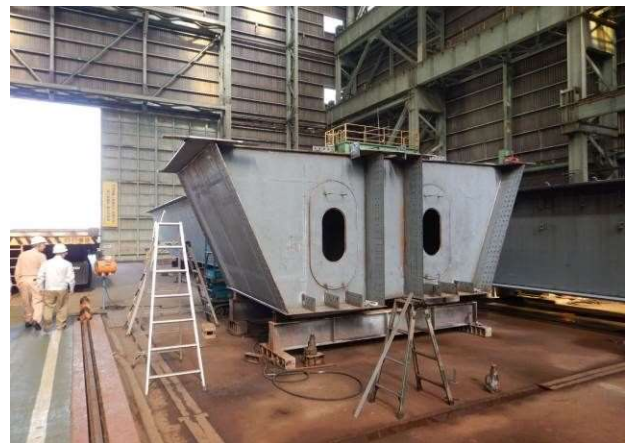
高知南国道路の高須工区で施工される鋼桁
